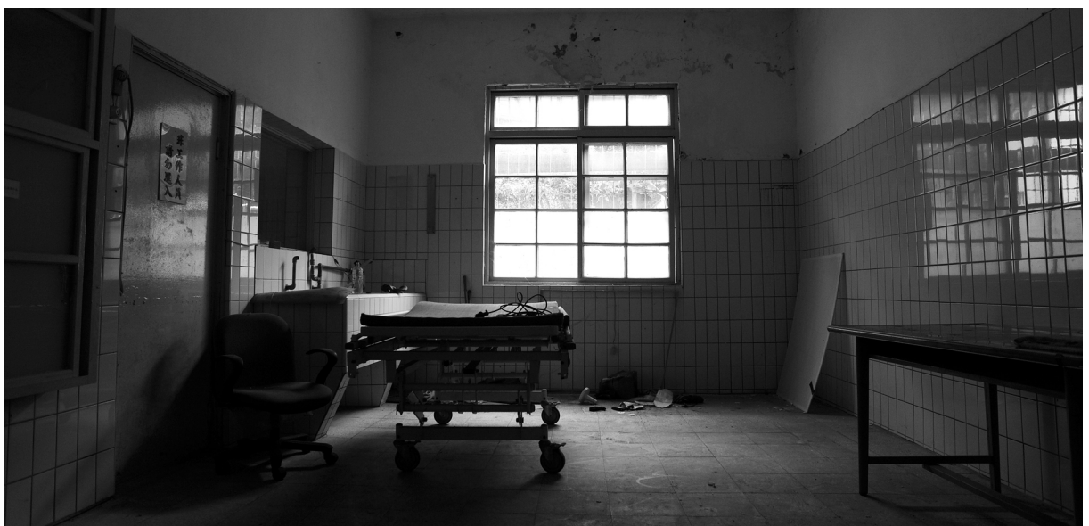
旧地区の診療病棟の一室。医療機材が新病棟に運び出されベットだけが残されていた。旧病棟は放置され、急速に老朽化が進んでいる
